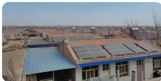
屋顶光伏建设
