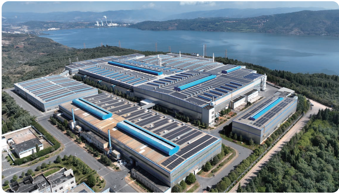
云铝股份屋面光伏发电设施
